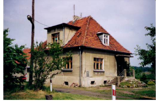
Das Haus an der Oderschleuse
