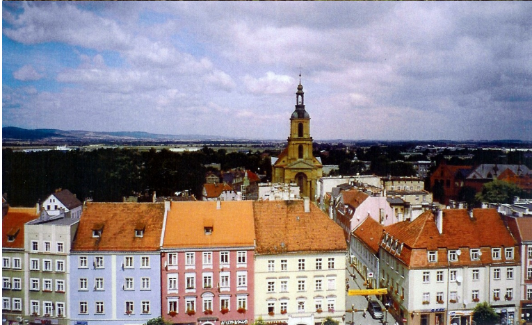
Die ev. Langhans-Kirche in Reichenbach
