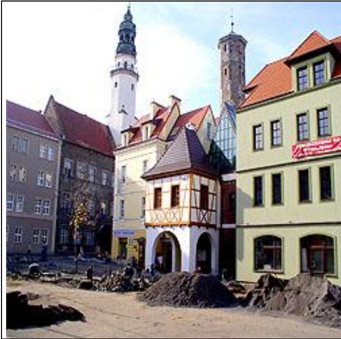
Sanierung um das Rathaus von Lauban
