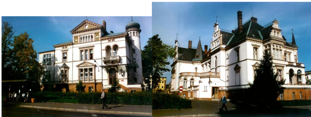
Dierig-Wohnhäuser um 1995, Aufnahmen privat, Fotomontage. Dahinter, verdeckt die neue Hauptverwaltung.
